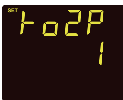
Fig 3-33 RO2 Alarm Parameter Setting
